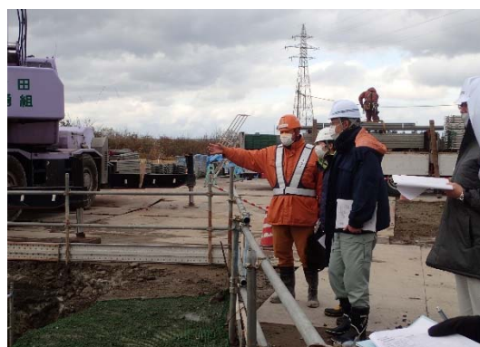
現場での状況確認（中央排水機場）
