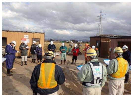
工事担当者からの説明（新渡その1）
