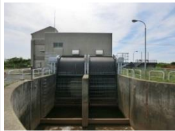
西野排水機場 (改修) 施工中
