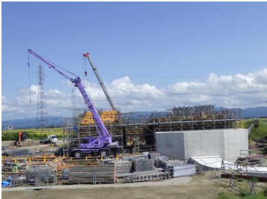
西野排水機場建設の様子
