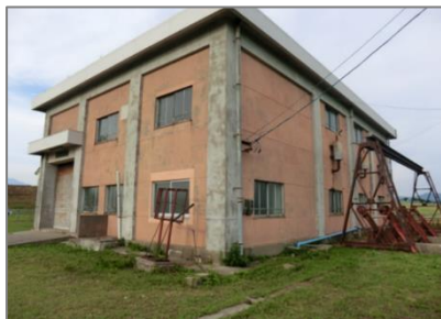
既設毒蛇排水機場全景
