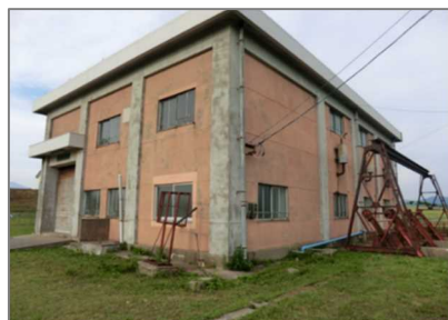
既設毒蛇排水機場全景
