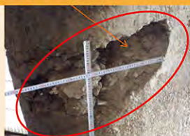
鉄筋の破断
