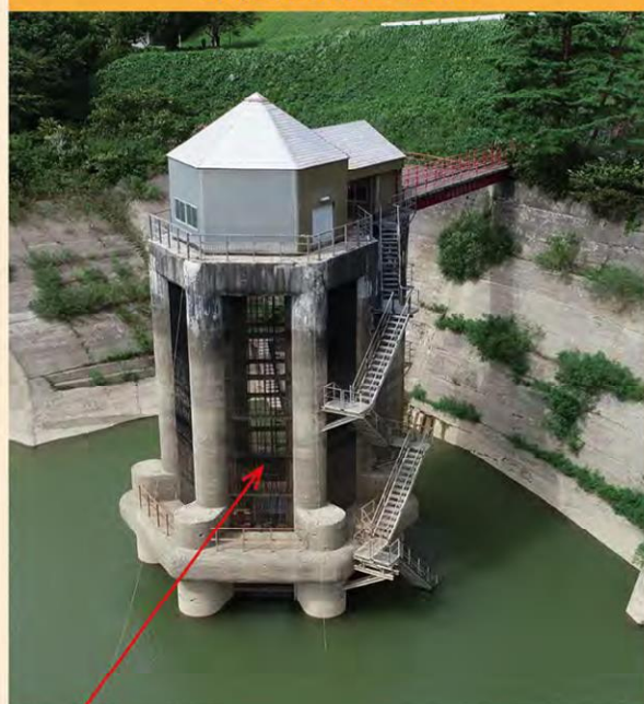
皆瀬取水塔の現状
