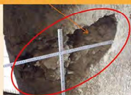
鉄筋の破断
