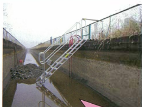
仮設備階段 設置角：約45° 踏板幅：55cm 手摺高：85cm
