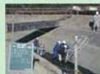
レーダ探査による劣化状態の調査
