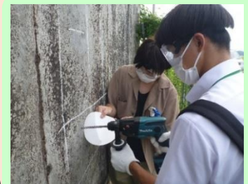
機能診断調査(仙北平野地区)
