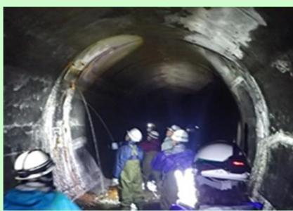
導水幹線用水路（トンネル）の漏水
