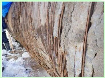
幹線導水路の鋼線露出
