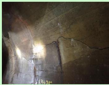
導水路トンネルのひび割れ
