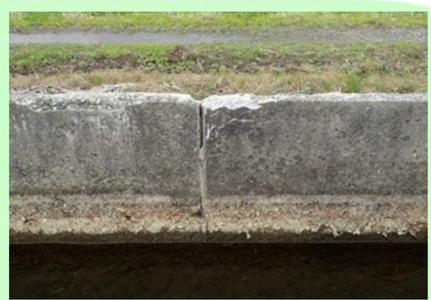
幹線用水路のひび割れ、粗骨材の露出
