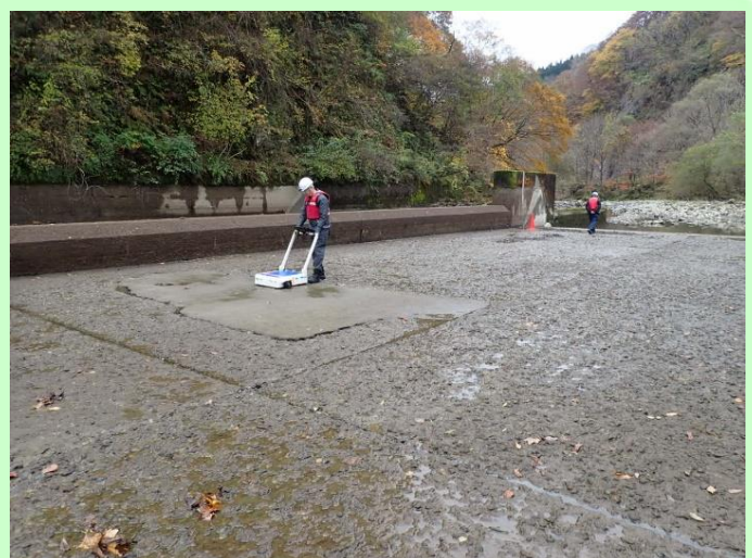
素波里頭首工 河床部空洞調査状況
