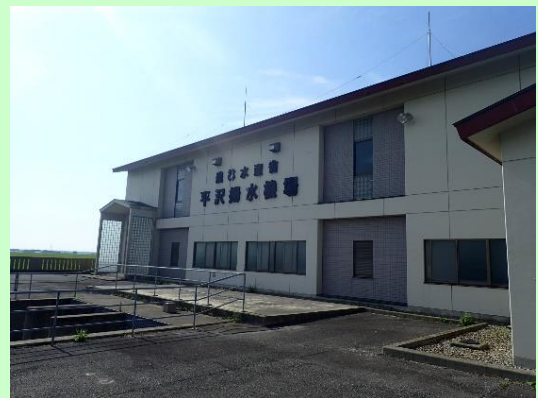
平沢揚水機場（全景）
