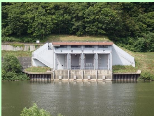
草薙頭首工（全景）
