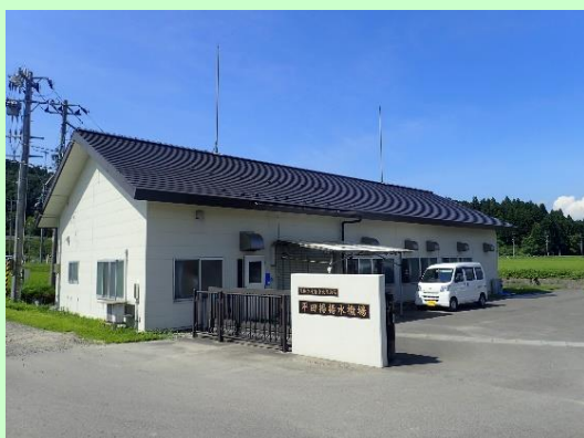
平田揚揚水機場（全景）
