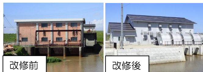
▲毒蛇排水機場
