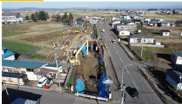
施工中の状況
