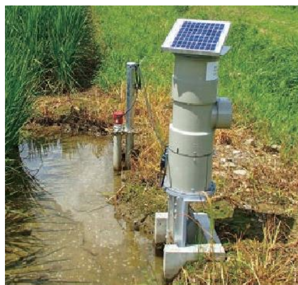
ICT自動水位調整型排水調整器の設置例 〔(株)クボタケミックス 「WATARAS」カタログより〕
