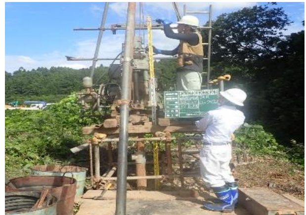
八幡幹線用水路（ボーリング調査）
