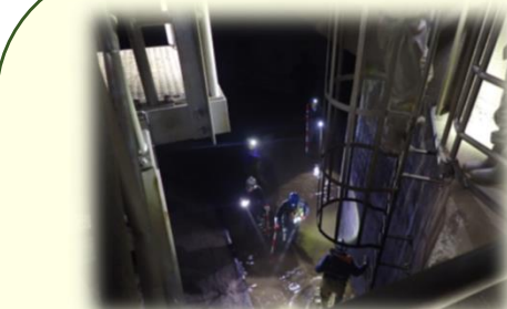
R6.11.20 投稿（トンネル調査）
