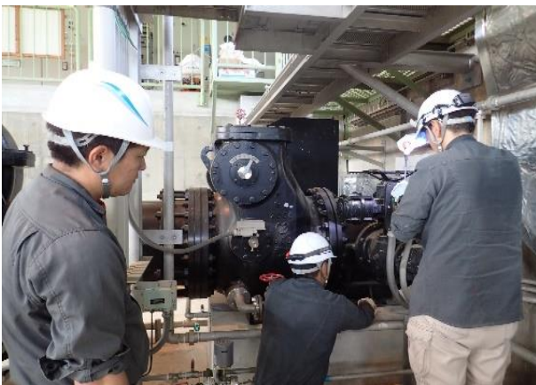
平田揚揚水機場（機能診断状況）
