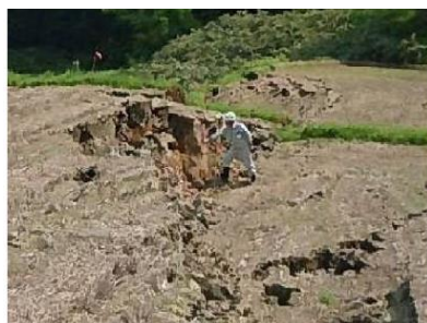
農地の被災状況（H21）
