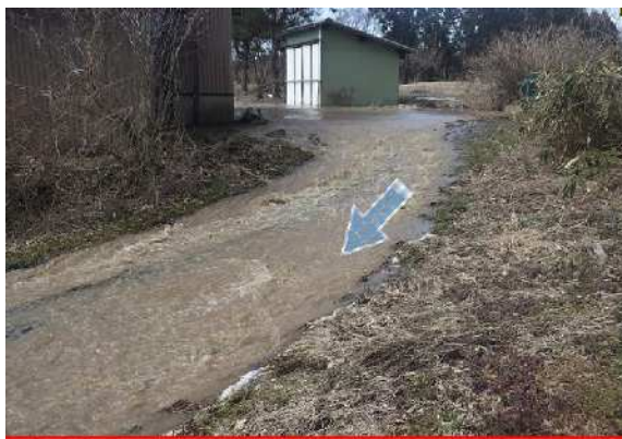
第2号導水路漏水状況①
