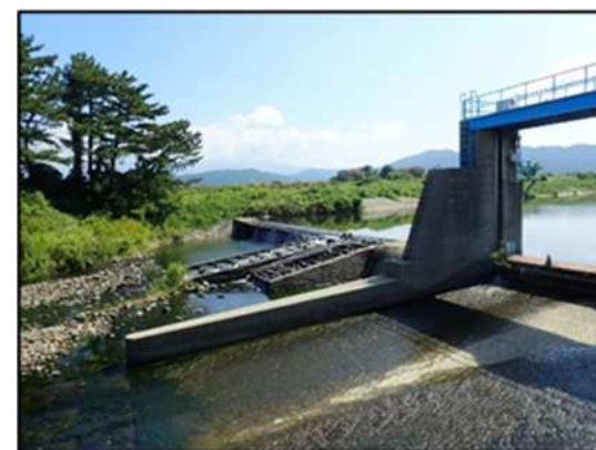
下井皿頭首工
