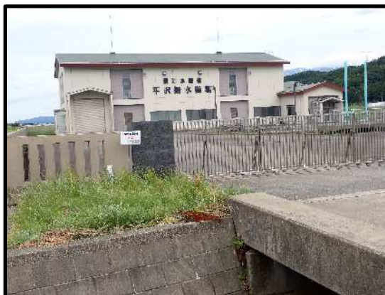
平沢揚水機場
