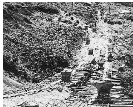
山王海ダム建設の様子(トロックによる用土運搬)
