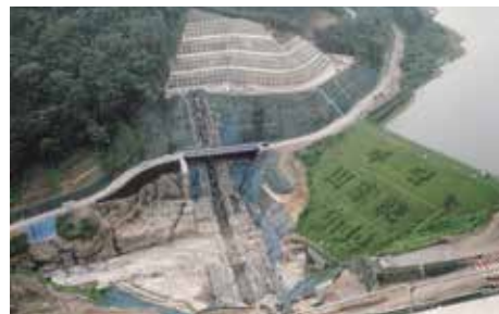
旧ダムの堤体を取り込んだ新山王海ダムの建設
