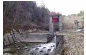
葛丸上流頭首工
