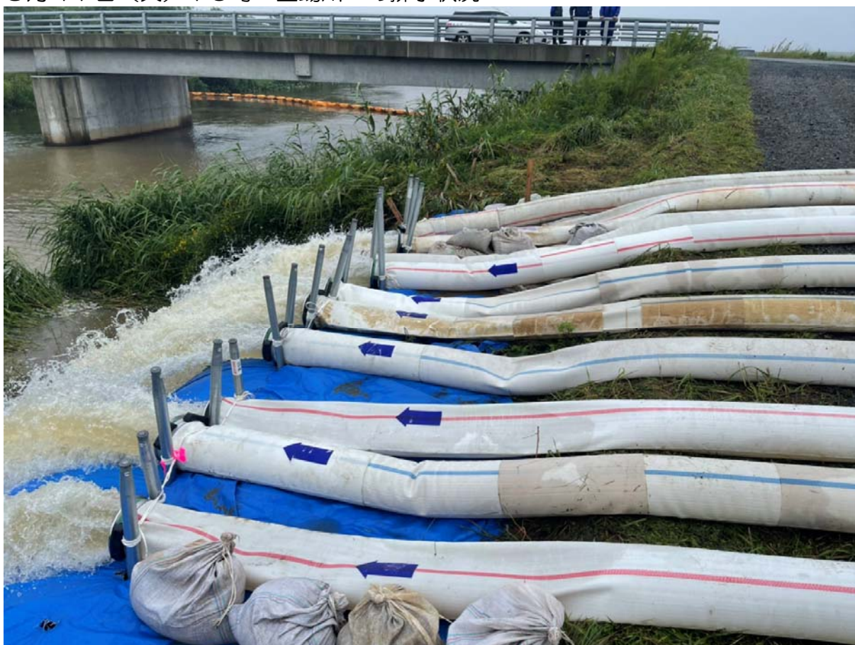
8月17日（火）15時 土場川への排水状況
