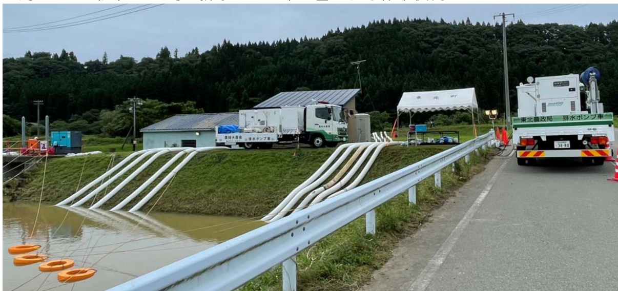
8月17日（火）15時 排水ポンプ車2台による作業状況
