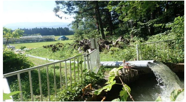
吐水槽へ導水
