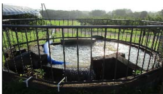
吐水槽へ導水
