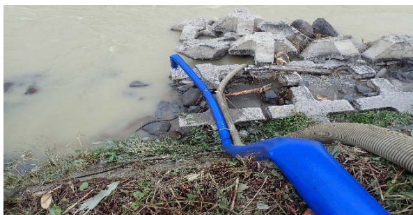
銅山川より取水
