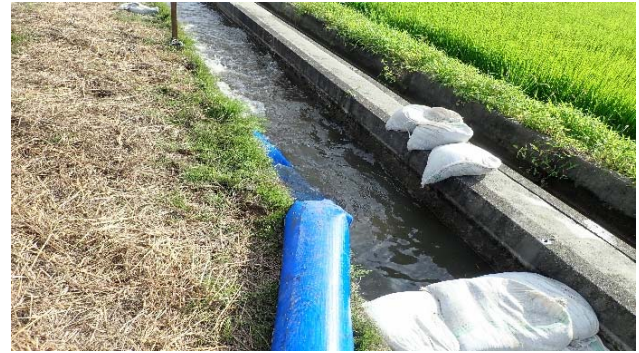
用水路へ導水
