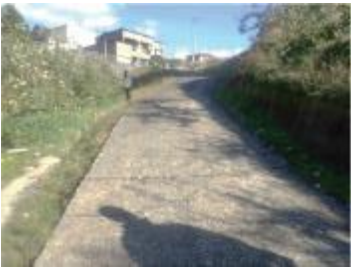
(1) コンクリート舗装 全体
