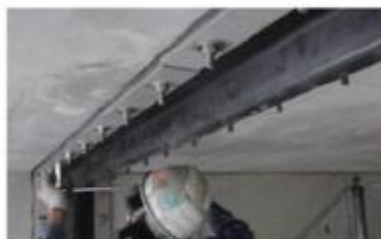
押さえ板取付状況
