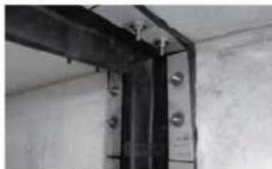
仕上がり状況
