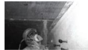
アンカー設置工
