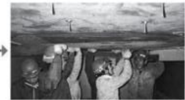
鋼板取付け工
