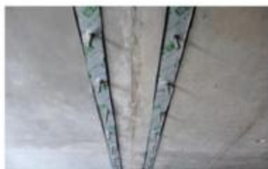
シーリング材貼付け状況
