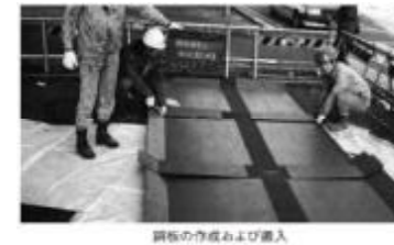
鋼板の作成および搬入
