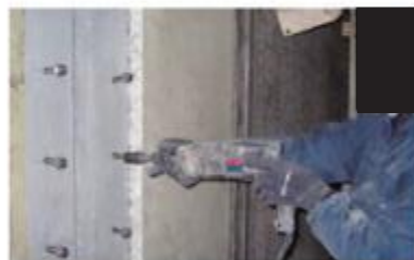
アンカー打ち込み状況
