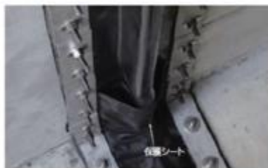
保護シート取付状況
