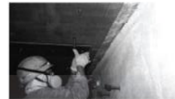
スプライス板取付け工
