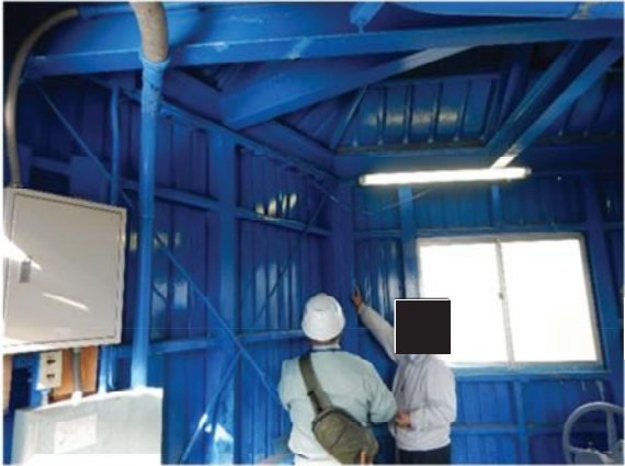
図3.3.2 上屋内部（目立った劣化無し）
