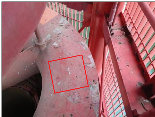
図 4.2.2 塗膜調査位置図（シリンダゲート扉体）
