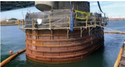
図 4.7.7 施工状況（φ8500×L14156×H7000H）
