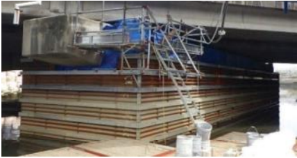
図 4.7.8 施工状況（B5418×L21432×H4500）
