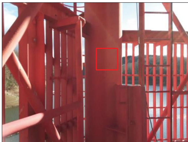
図 4.2.4 塗膜調査位置図（取水塔柱部材）
