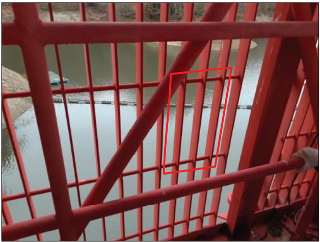
図 4.2.3 塗膜調査位置図（取水塔スクリーン）
