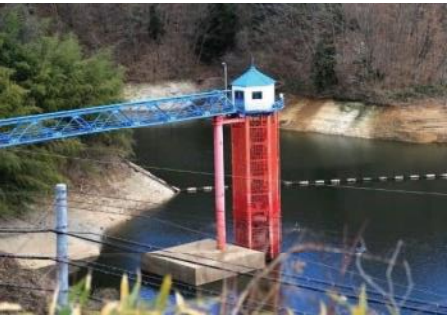
図1.1 千五沢ダム取水塔
