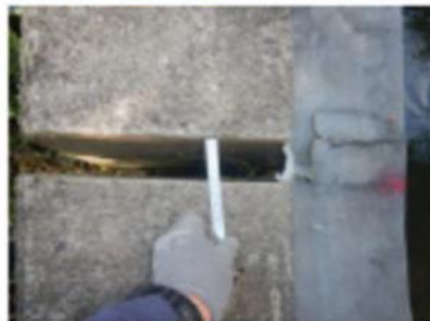
【橋台部の遊間状況(A1橋台部)】
