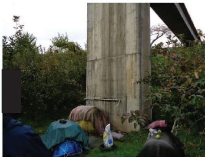
【P1橋脚付近にもリンゴの木①】
