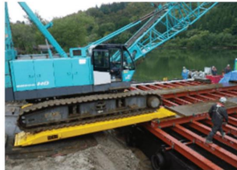
【クレーンの進入イメージ】
