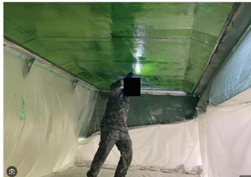
【アラミド繊維シート工法の施工イメージ】
