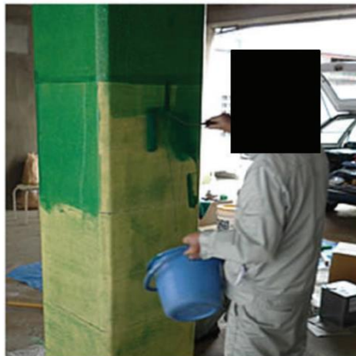
【アラミド繊維シート工法の施工イメージ】
