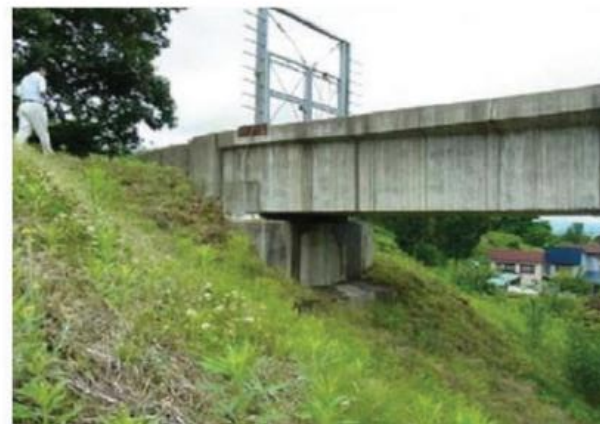
【温湯左岸幹線用水路第2号水路橋 上部工】
