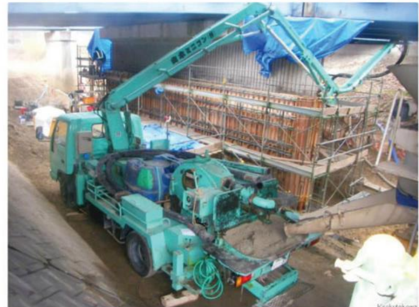
【RC巻立の施工イメージ】
