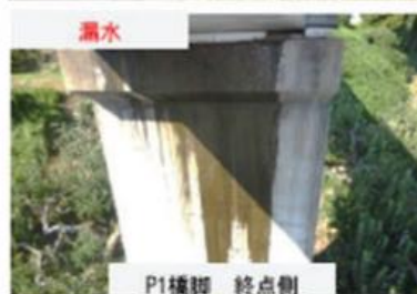
P1橋脚 終点側
