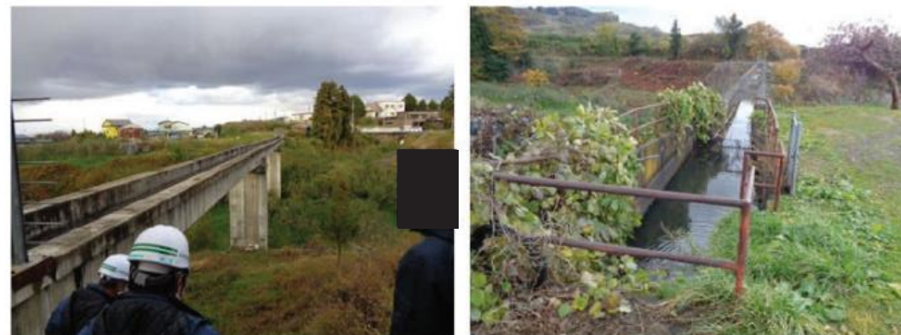
【上部工(水路工)の状況】
