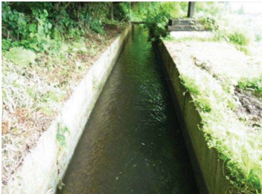
【温湯左岸幹線用水路 No.10付近】
