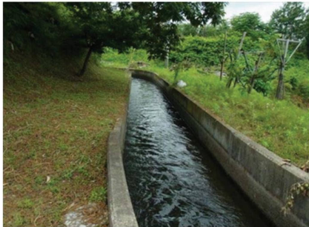
【温湯左岸幹線用水路 No.38付近】
