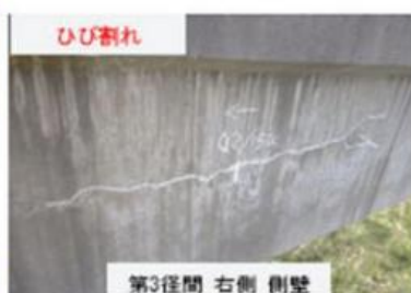
第3径間 右側 側壁
