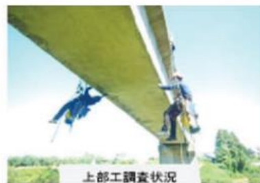
上部工調査状況
