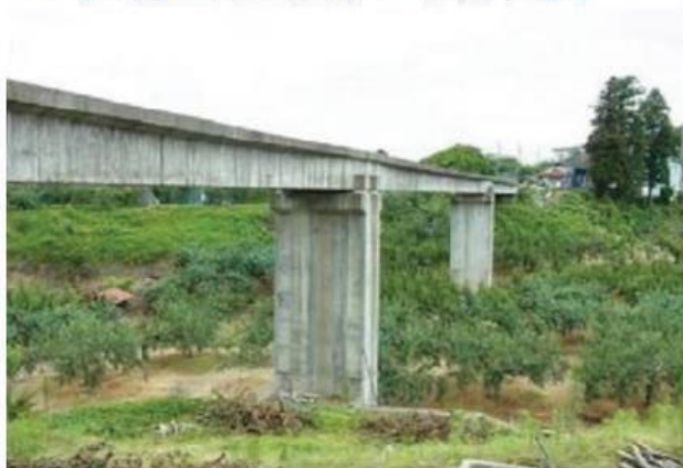
【温湯左岸幹線用水路第2号水路橋 全景(東側)】
