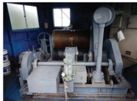
【シリンダーゲート開閉装置】
