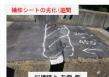
P1橋脚上 右側 側
