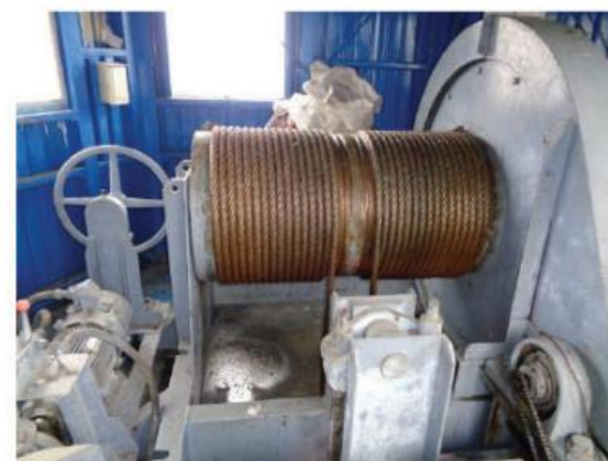
【シリンダーゲート開閉装置】
