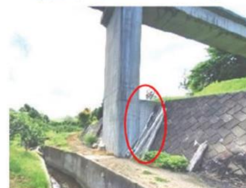
【P2橋脚に現存するウイング】
