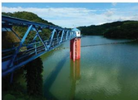
【千五沢ダム取水塔 全景】
