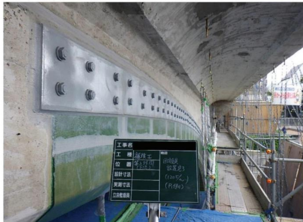
【鋼板接着工法の施工イメージ】
