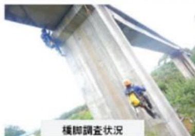
橋脚調査状況
