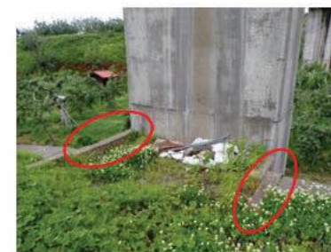
写真- 3.10.1 後付けウイング設置状況
