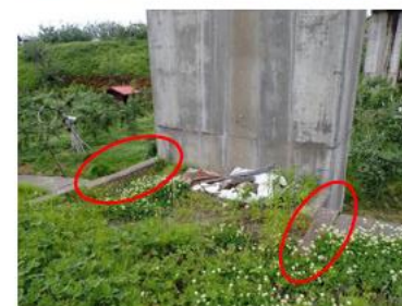
写真- 3.10.1 後付けウイング設置状況
