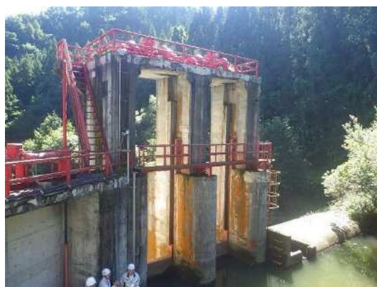
土砂吐ゲート上流側
