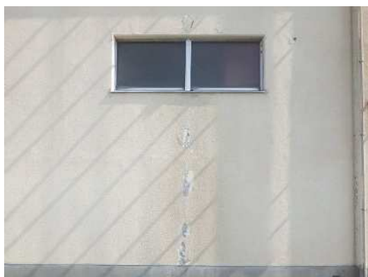
建屋外壁（南面）
