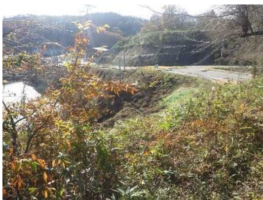
管理橋入口より工事用道路予定地を望む
