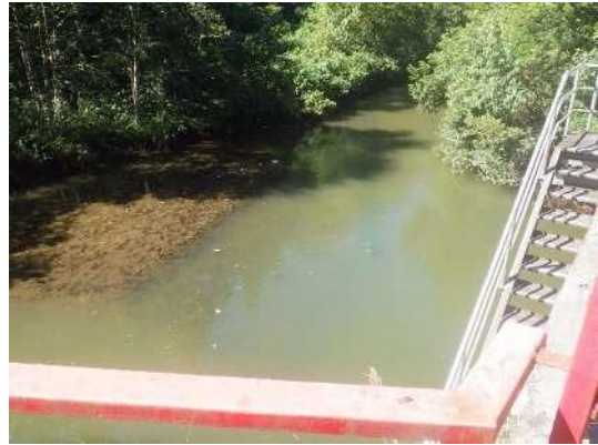
土砂吐ゲート上流 堆砂状況
