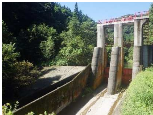
固定堰および土砂吐ゲート下流側
