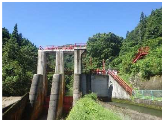
土砂吐ゲートおよび取水ゲート下流側
