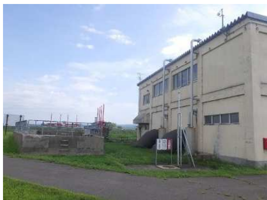
吐水槽及び建屋外観
