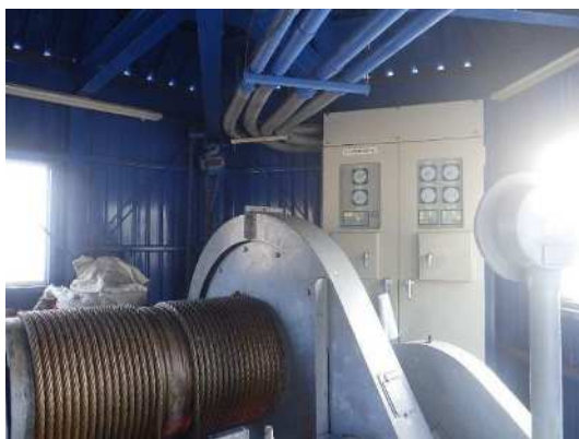
取水塔上屋内部
