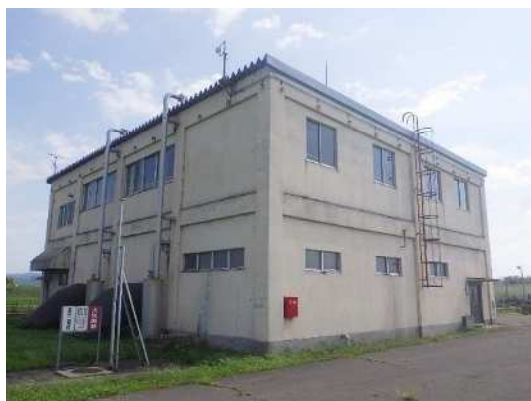
建屋外観（南西から撮影）
