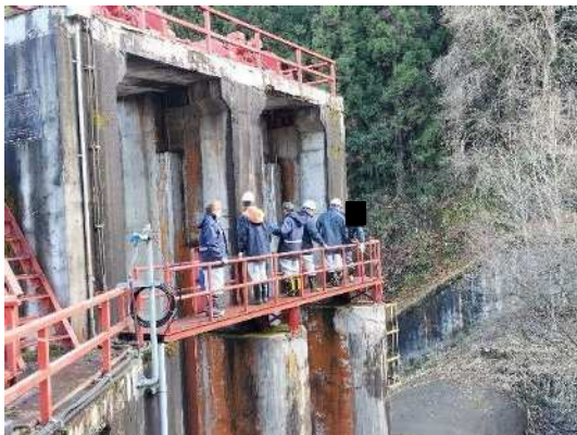
土砂吐ゲート上流側
