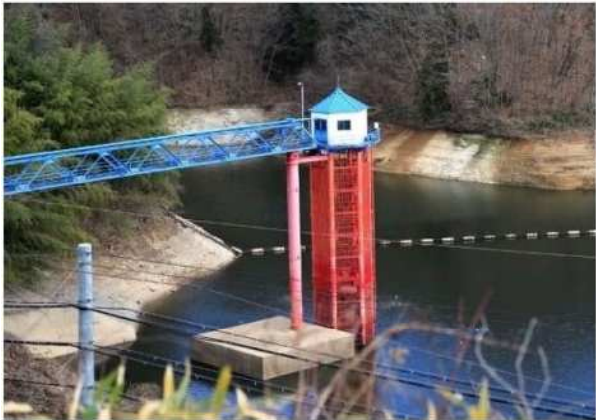
千五沢ダム取水塔 現況写真
