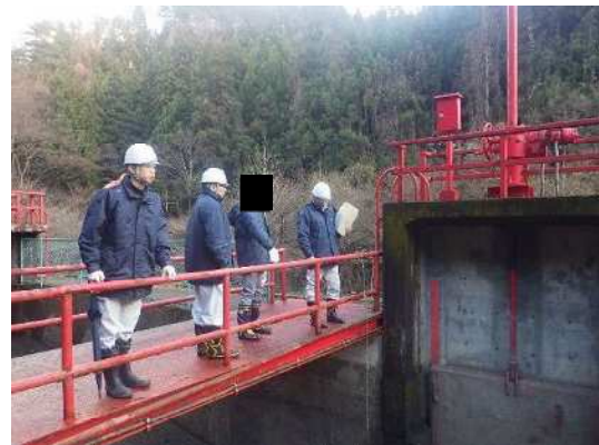
沈砂池土砂吐ゲート付近
