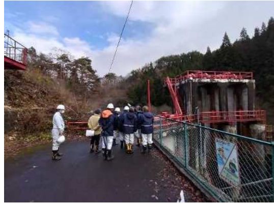
左岸側より望む
