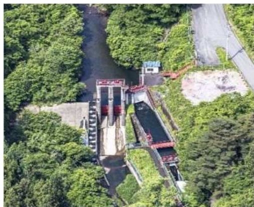
稲荷頭首工 空撮写真
