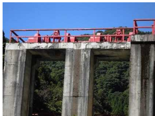
土砂吐ゲート上部
