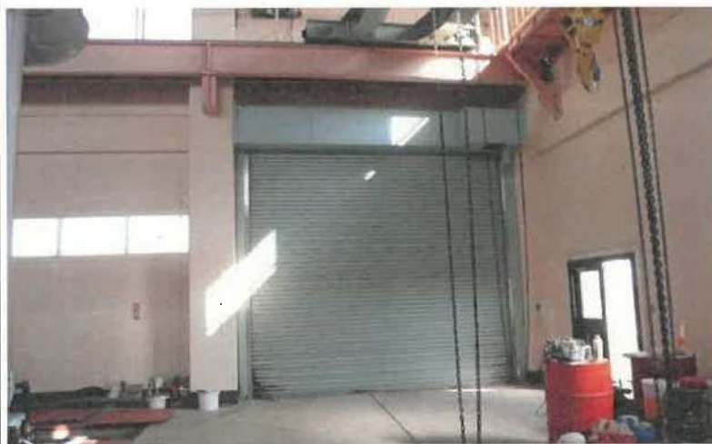
⑦ 建屋内 シャッター
