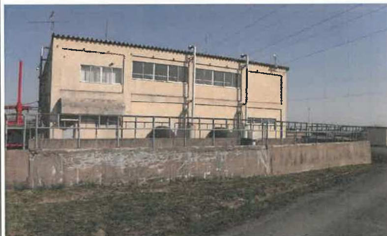
② 中泉排水機場 前景 吐出水槽側から
