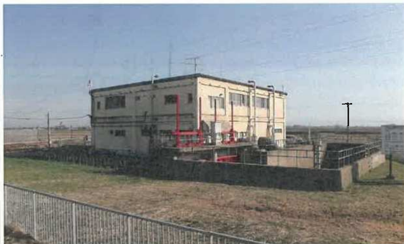
① 中泉排水機場 前景 十川側から
