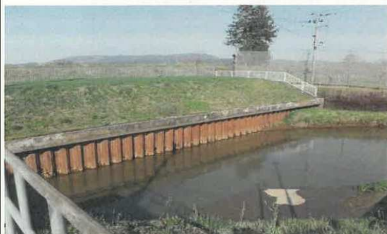
④ 導水路 鋼矢板状況
