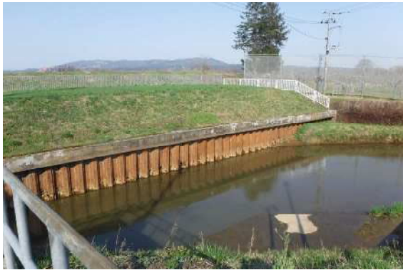
写真 鋼矢板水路腐食状況（24. 04. 15）
