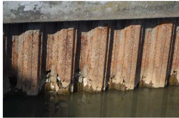
写真 鋼矢板水路腐食状況（24. 04. 15）
