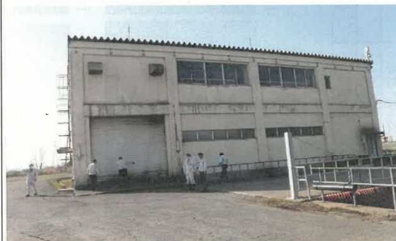
③ 中泉排水機場 前景 排水路側から
