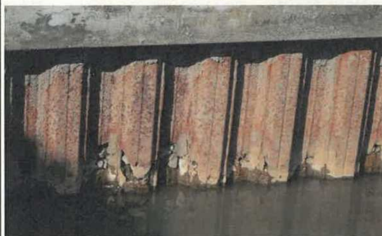
⑤ 導水路 鋼矢板状況
