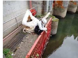
取水口スクリーン状況
