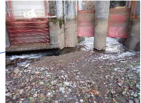
写真、土砂吐ゲート2門を全開した状態
