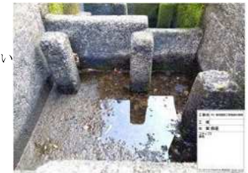
写真、粗骨材が全体的に摩耗
