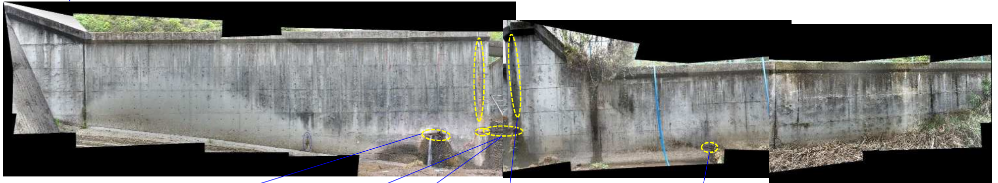
型取りによる骨材露出調査
