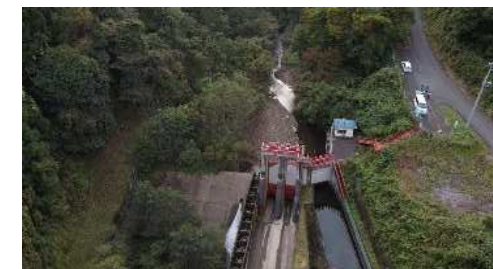
写真、固定堰を越水させる
