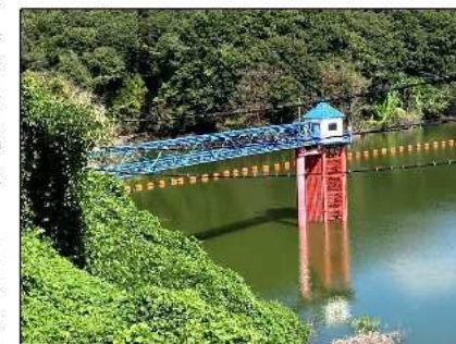
【写真-1.1 千五沢ダム取水塔の概況】
