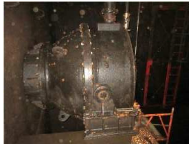
バルブ背面の吊り金具
