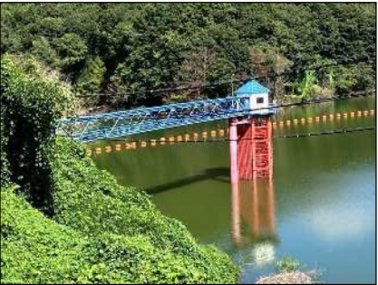
【写真-1.1 千五沢ダム取水塔の概況】
