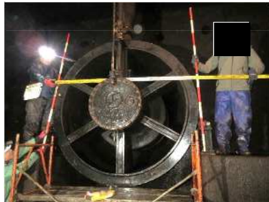
バルブ上部の空気管、吊り金具
