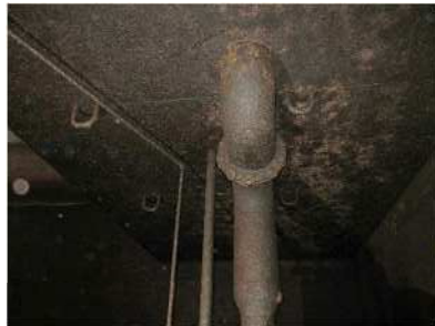
バルブ上部の空気管、吊り金具
