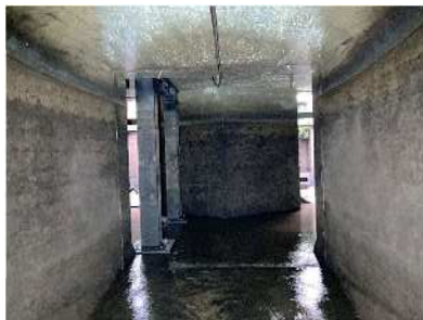
トンネル下流端より調整池側を撮影
