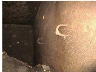
バルブ背面の吊り金具
