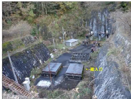
【写真-4.3.1 南北調整池(上流側より下流側を望む)】
