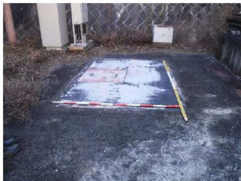
搬入用開口寸法測定 ※W1.7m×L2.5m (内寸)
