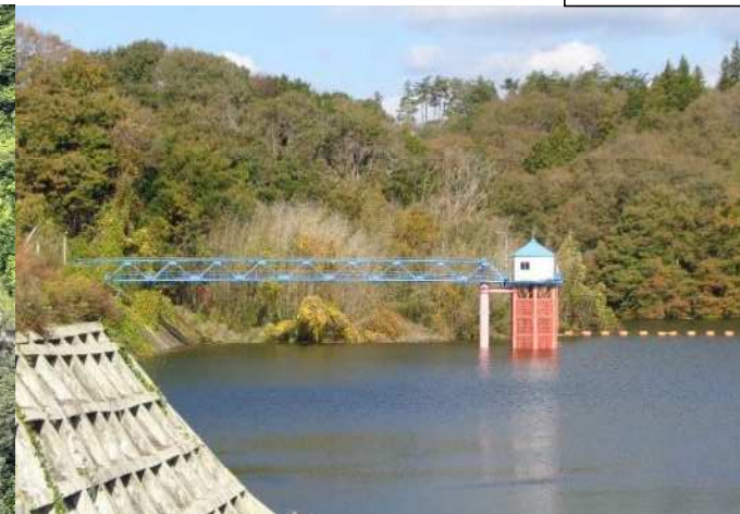
母畑地区 (千五沢ダム取水塔)
