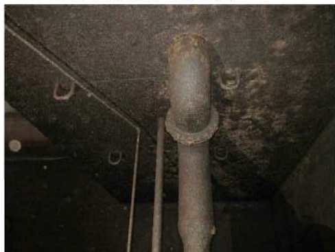
バルブ上部の空気管、吊り金具
