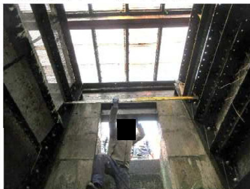
左岸側除塵ネット上端の寸法測定 ※W=1.65m
