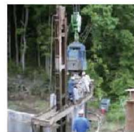
電動式バイプロハンマ + ジェット併用法
