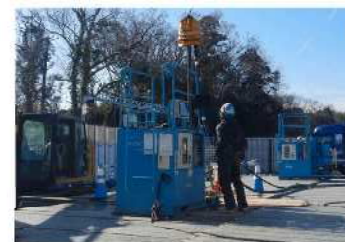
V1タイプ 写真 施工機械写真
