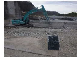
写真、ツインヘッダによる切断
