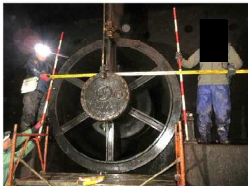
バルブ上部の空気管、吊り金具
