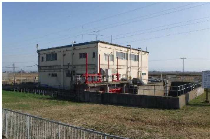
浅瀬石川二期地区 (中泉排水機場)
