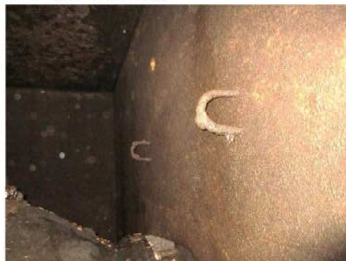
バルブ背面の吊り金具
