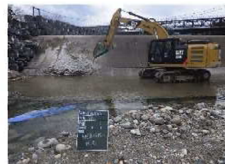
写真、大型ブレーカーによる固定堰仕切り作業
