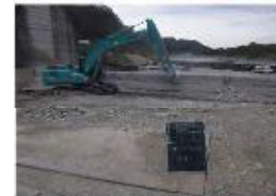
写真 ツインヘッドによる取削
