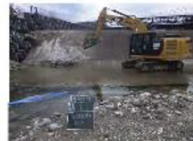
写真 大型ブレイカーによる固定堰の破砕作業
