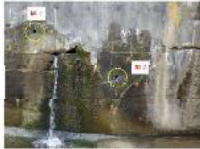
写真：漏水箇所コンクリートコア採取箇所
