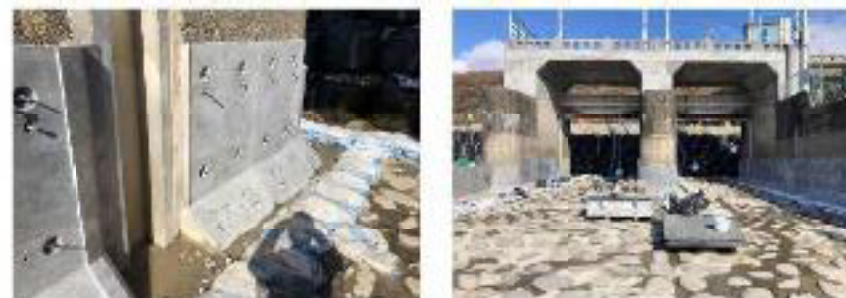
写真。側壁下部の補強事例
