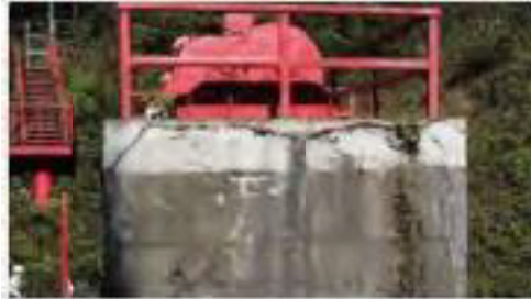
写真、既存の土砂吐（操作台天端の状況）
