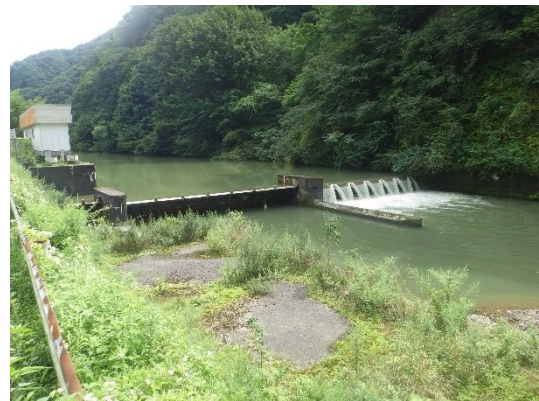
素波里頭首工（下流側より）
