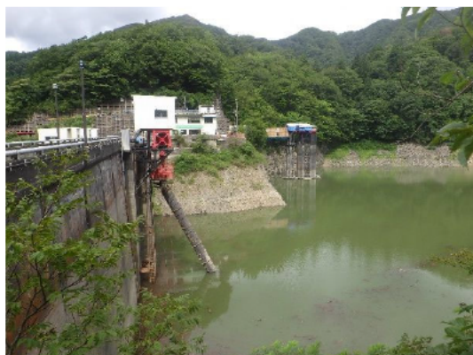
取水設備遠景
