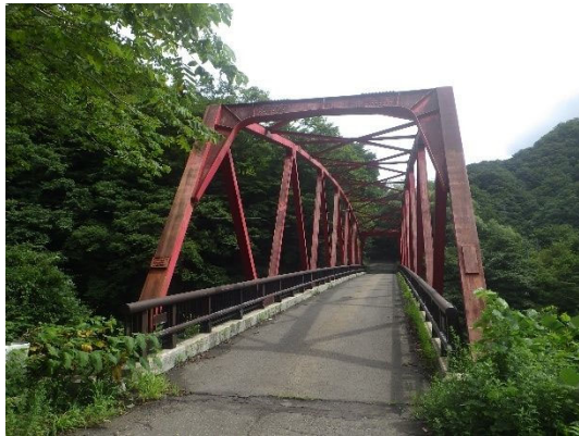
ダム右岸下流 橋梁その2
