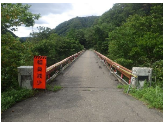
ダム右岸下流 橋梁その1
