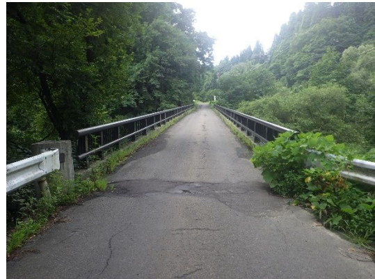
ダム右岸下流 橋梁その3
