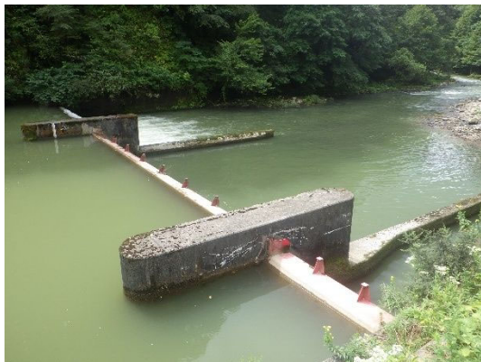
素波里頭首工（上流側より）
