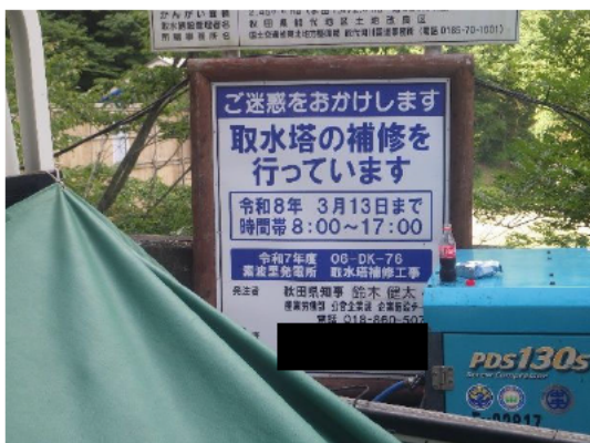
取水塔補修 県工事
