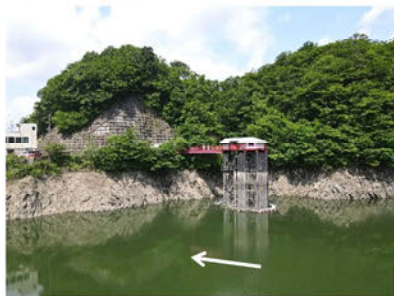
素波里ダム湖右岸状況写真
