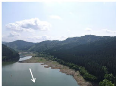
素波里ダム湖左岸状況写真
