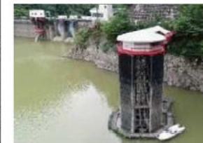
素波里取水塔
