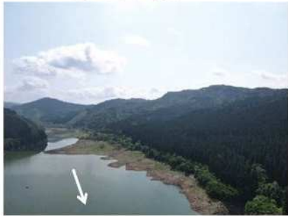
素波里ダム湖左岸状況写真
