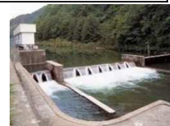
素波里頭首工
