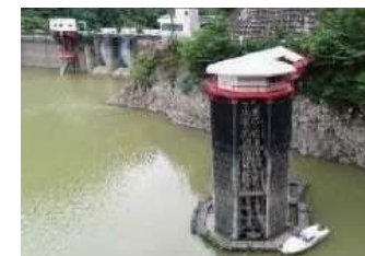
素波里取水塔
