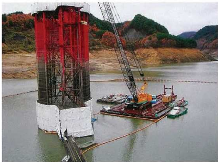
山形県 水窪ダム取水設備改修工事
