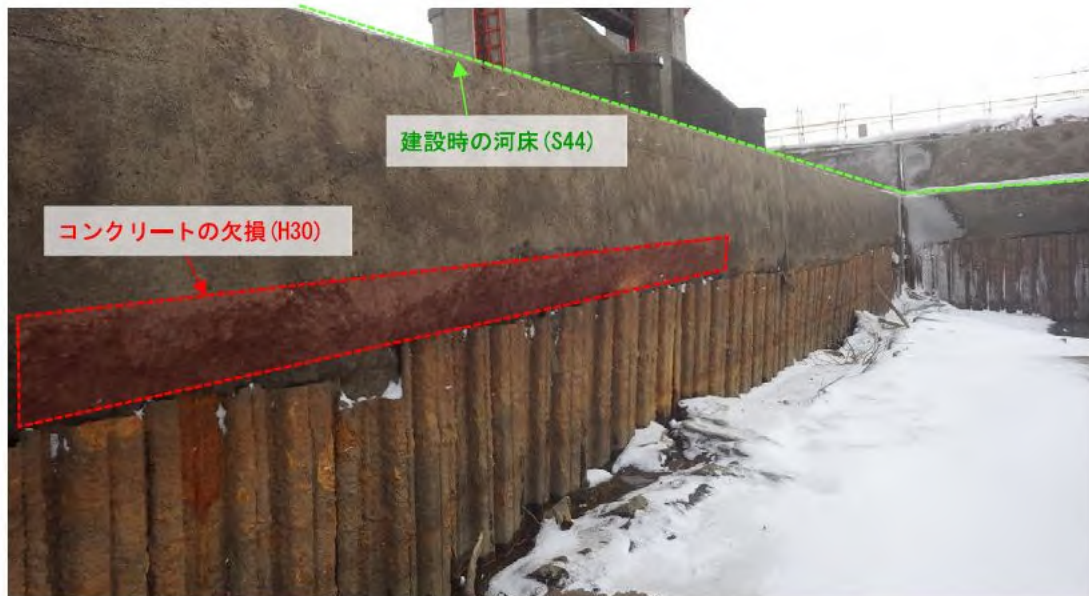
図 3-5 改築直前の河床の状態 (2/2)
