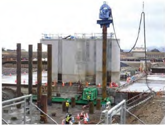
鋼管杭打設状況(パイプロハンマー)
