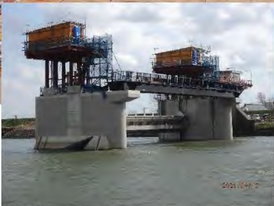
4期完了時点の堰柱仮設状況
