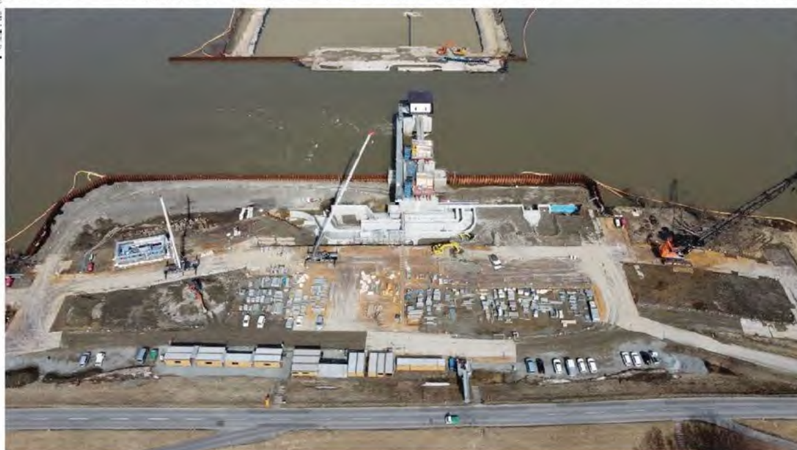
6期工事施工状況(令和5年3月上旬)
