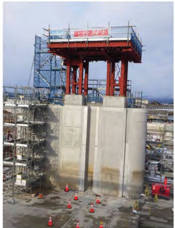
P2仮設構台設置状況
