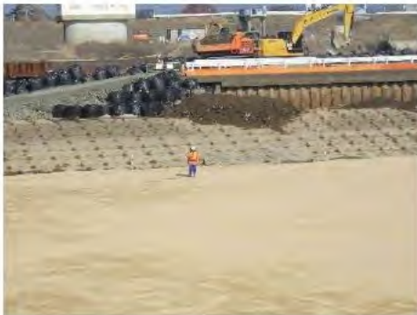
護床工基盤面状況(2期完了時)
