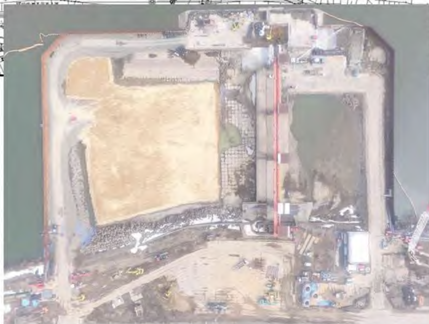
洗掘部埋戻 完了状況
