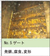
No. 5 ゲート 腐食、サイドローラ不回転
