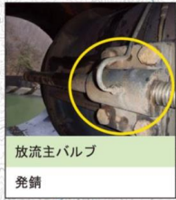
放水弁(放流主バルブ) 発錆
