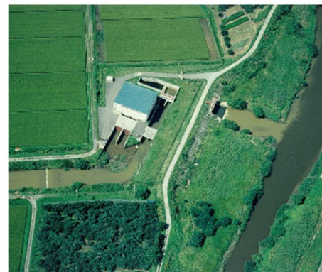
中泉排水機場
