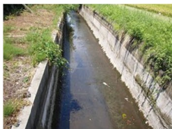
横沢幹線用水路
