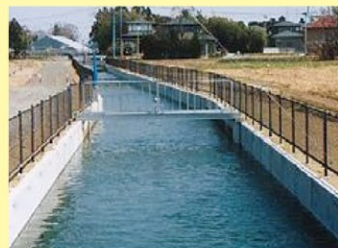
大型フリウムによる改修
