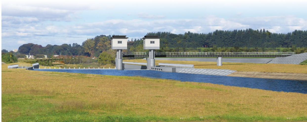
浅瀬石川統合頭首工（新設）
