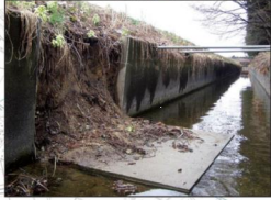
上堰幹線用水路
