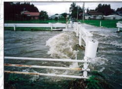
中央幹線排水路
