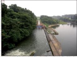
下堰幹線用水路取水口
