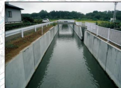
中央幹線放水路(改修後)
