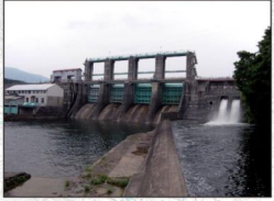
石羽根ダム下堰幹線放水口
