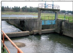
中央幹線排水分水工
