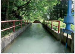
上堰幹線用水路
