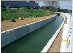
上堰幹線用水路(改修後)
