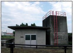
鉄道南排水機
