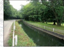
下堰幹線用水路
