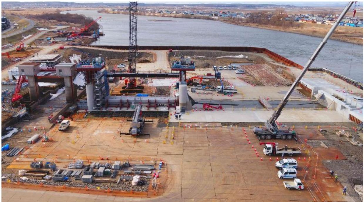
4期工事施工状況（洪水吐鋼製ゲート設置完了状況）
