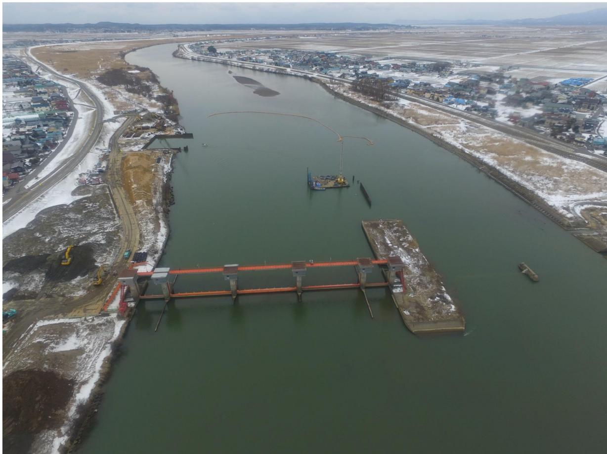
1期工事施工状況（仮締切鋼矢板打設（台船））
