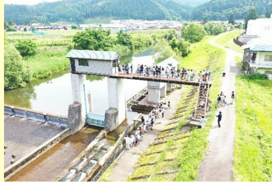
新一の堰頭首工見学
