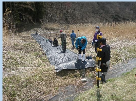
鳥獣被害防止用の電気柵設置作業
