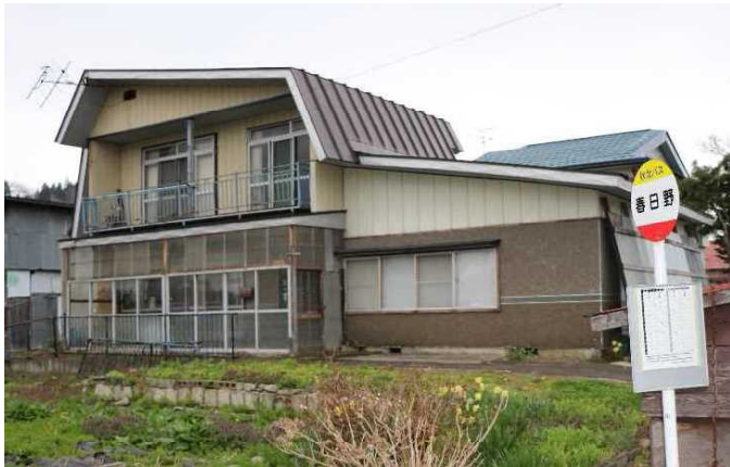
改修して南白神ベースになる空き家
