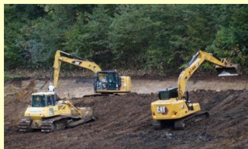
農用地の保全 工事中の農地整備事業
