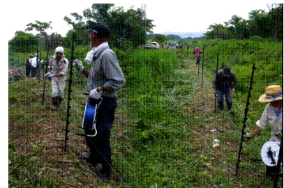
住民による電気柵設置作業
