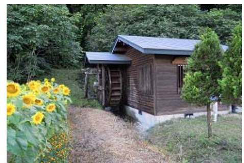
整備された水車小屋
