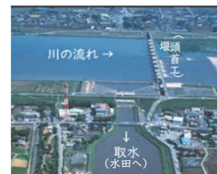
河川からの取水施設 （頭首工）
