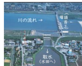
河川からの取水施設 （頭首工）
