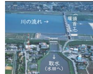
河川からの取水施設 （頭首工）
