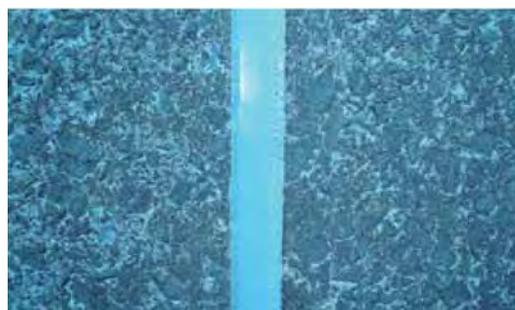
【田沢疏水右岸幹線用水路】目地補修、ゲート補修
